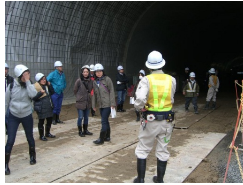
○ネクスコ東日本 磐越自動車道 吉津トンネル工事
