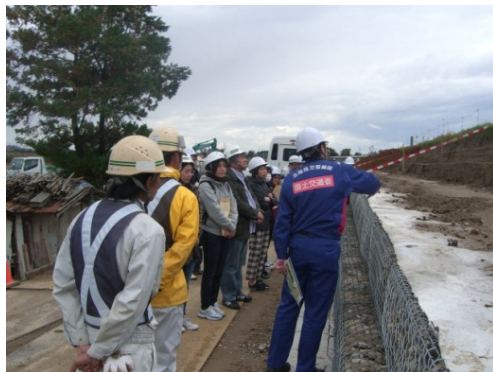
○阿賀野川河川事務所 六郷堤防浸透対策工事
